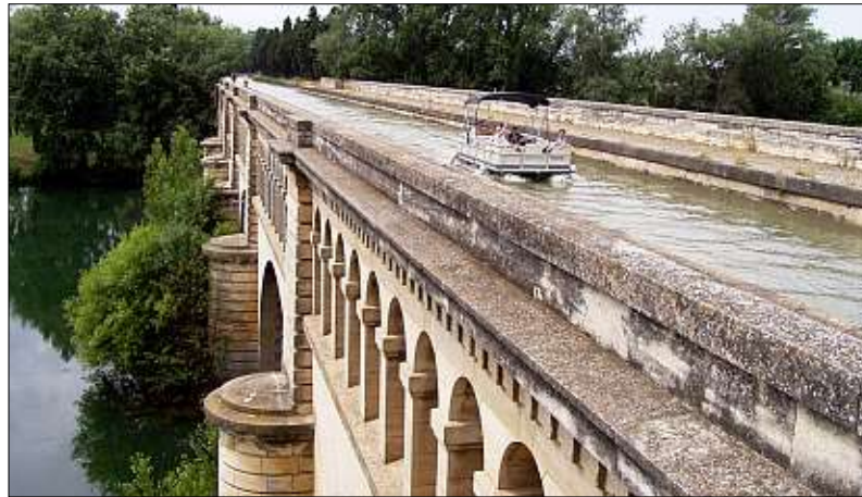
Die Pont Canal de Cacor an der Ecluse de L'Orb zwischen Béziers und Fonsérannes von 1858 ist 190 Meter lang, zehn Meter hoch und soll unter Denkmalschutz gestellt werden. Die Ufer sind mit Lavastein befestigt.
